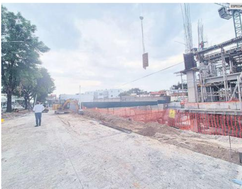
OBRAS. Trabajadores concluyeron la reparación del socavón registrado en la lateral de López Mateos (cerca de Mariano Otero). Una construcción privada aledaña fue señalada como la causante, por lo que asumirá los costos de la reparación.
