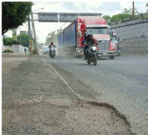
■ Sobre Lázaro Cárdenas, al cruce con Fuelle, la carpeta asfáltica está muy deteriorada.
