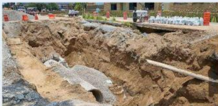
■ La vía es reparada por autoridades.
