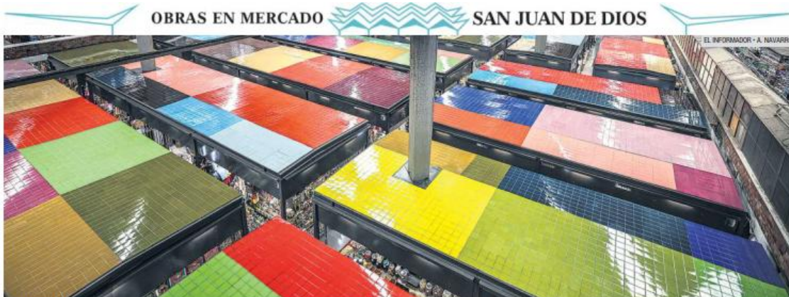
NUEVA CARA. El mercado luce nuevas instalaciones eléctricas, sistema contra incendios, piso renovado, mejoras estructurales y el mosaico "Refuerzo común", del artista José Dávila, como parte de la rehabilitación con una inversión de 37.5 millones de pesos.
