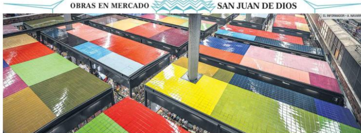
NOVA CARA. El mercado luce nuevas instalaciones eléctricas, sistema contra incendios, piso renovado, mejoras estructurales y el mosaico "Refuerzo común", del artista José Dávila, como parte de la rehabilitación con una inversión de 37.5 millones de pesos.
