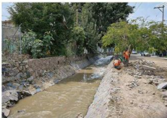
Las autoridades de Zapopan realizaron ayer trabajos del limpieza del arroyo y la zona afectada.
