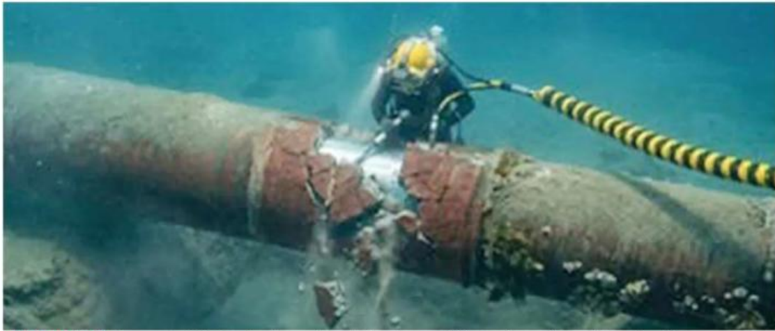
REPARACIÓN. Buzos especializados localizaron el punto donde se perdió la presión por la fuga de combustible e iniciaron las labores de reparación en el ducto marino ubicado al norte de Ciudad del Carmen, Campeche.
