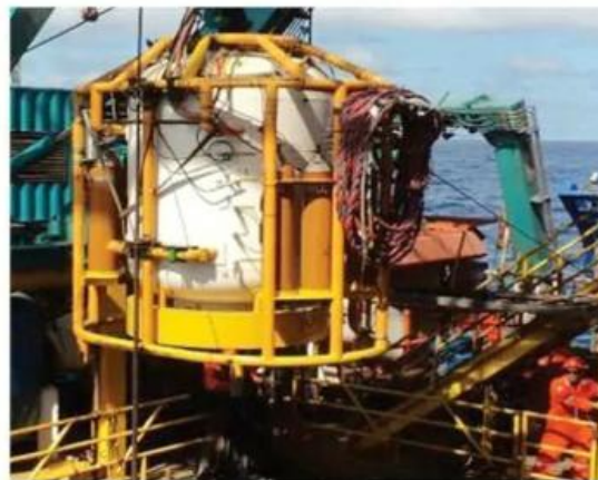
■ Pemex informó que trabajan en la habilitación de la envoltura metálica que cubrirá la zona afectada.
