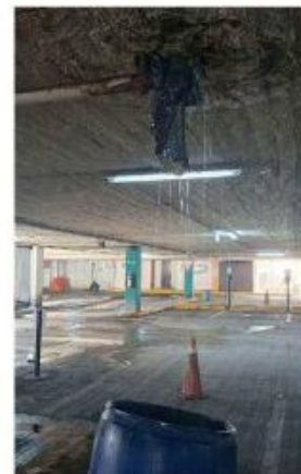
■ En uno de los puntos se colocó un bote para captar la caída de agua.
