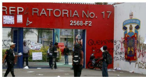
Así quedó la fachada de la Preparatoria 17 en Las Pintas.
