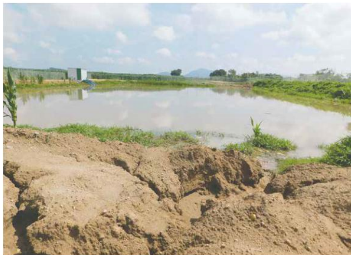
¿SOLUCIÓN? El fraccionamiento construyó una fosa para darle salida a aguas tratadas.
