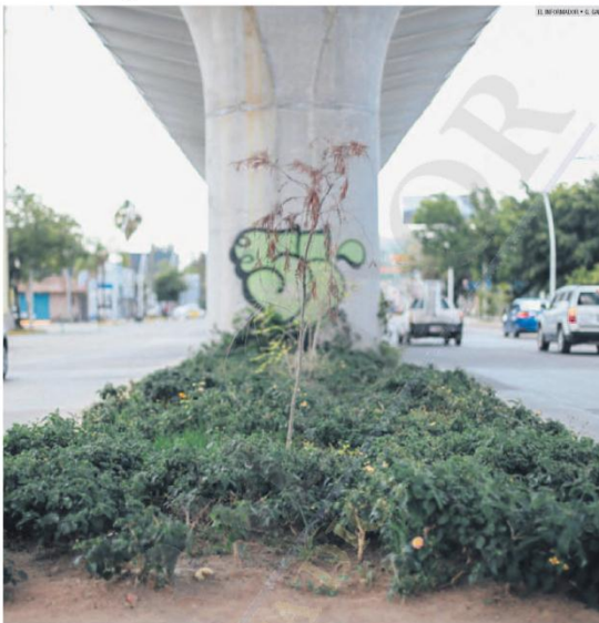
FALLAS. Las autoridades incurren en reponer más de 11 mil árboles en el corredor de la Línea 3. Y varios de los que sembraron están en malas condiciones (Avila Camacho).
