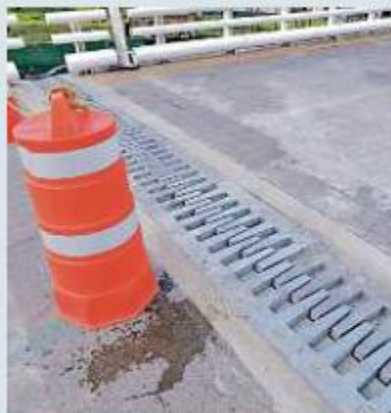
■ El Ayuntamiento reparó tres juntas de calzada dañadas en el paso elevado de Av. Patria y Acueducto.
