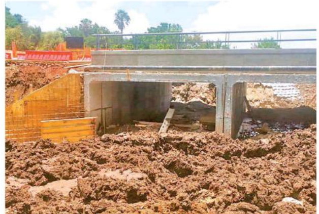
Los trabajos presentan un avance del 85 por ciento y se espera concluirlos a finales de agosto. Foto: Víctor Chávez
