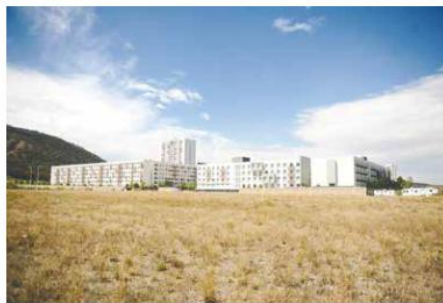
DIAGNÓSTICO. La habilitación de esta infraestructura representa una violación legal y al patrimonio de la ciudad, aseguran los arquitectos que participaron en Campus Party.
