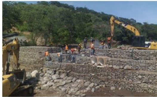
Se construyen tres gaviones. ESPECIAL
