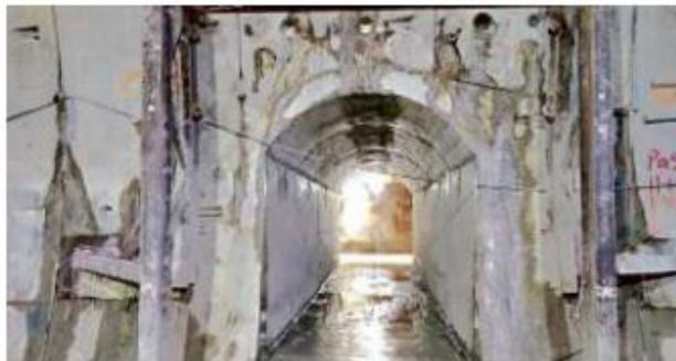
■ Una de las salidas de emergencia del túnel tiene filtraciones.
