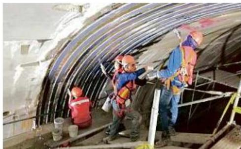
Algunas de las dovelas han sido reforzadas con fibra de carbono, ante el daño; esas piezas no pueden ser sustituidas.
