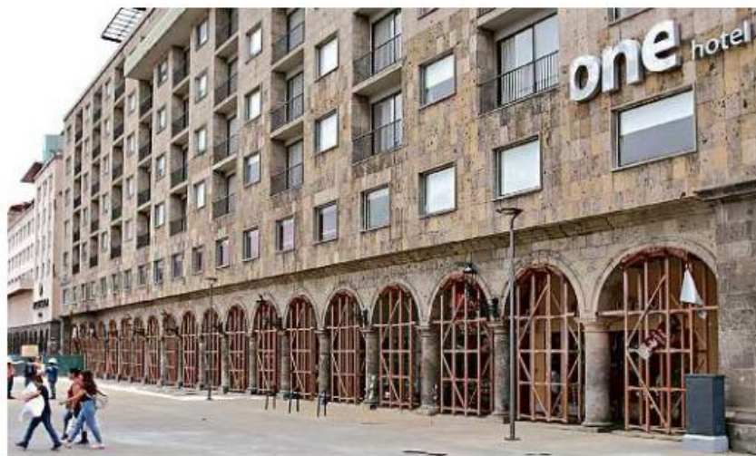
■ El Hotel One de Av. Alcalde tiene estructuras en sus portales para apuntalarlo.
