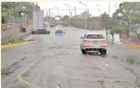
■ La inundación también impidió el paso por el único ingreso al Fraccionamiento Foresta Santa Anita.
