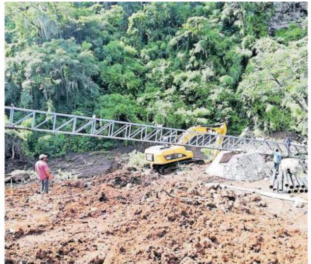
Se realizó la reconstrucción de la línea de agua potable La Pitayita-San Gabriel. CORTESÍA
