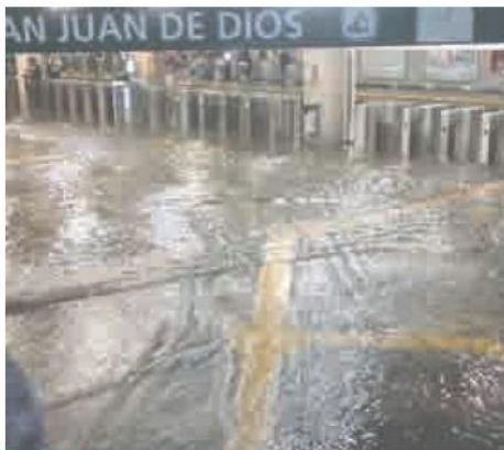
ESTRAGOS. El anegamiento en la estación San Juan de Dios provocó afectaciones para 16 mil 700 usuarios.
