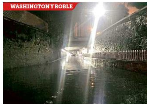
WASHINGTON Y ROBLE El paso a desnivel ubicado en esta zona tuvo que ser cerrado, pues el agua superó el metro de altura.
