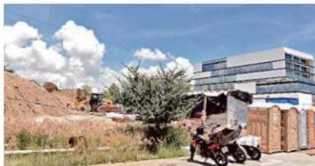
■ Se prevé que las obras del Parque Zapopan Central arranquen en la primera semana de septiembre.
