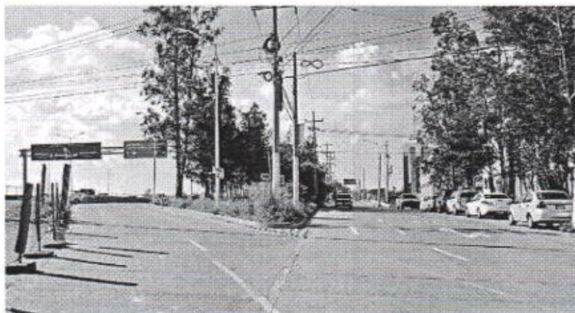
La incorporación a los centrales del Periférico, rumbo a la Avenida Vallarta, quedará ya cerrada.
