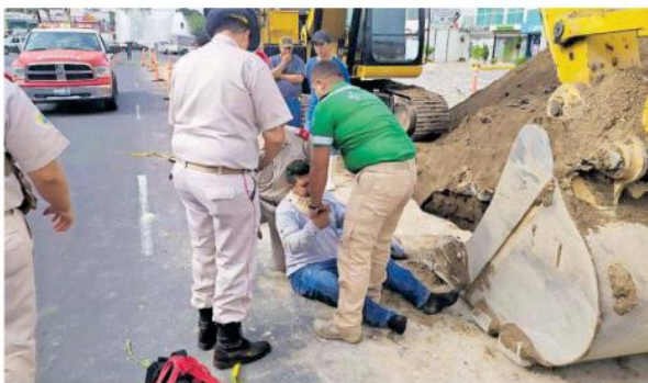
Al registrarse un derrumbe dos trabajadores quedaron sepultados. CORTESÍA
