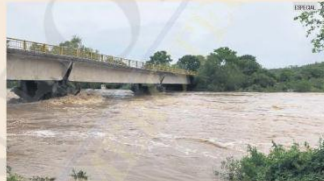
PREVENCIÓN. Ante la crecida del Río Membrasco cerraron por varias horas el puente que conecta el Estado de Colima con Cihuatlán. Por la tarde fue reabierto.
