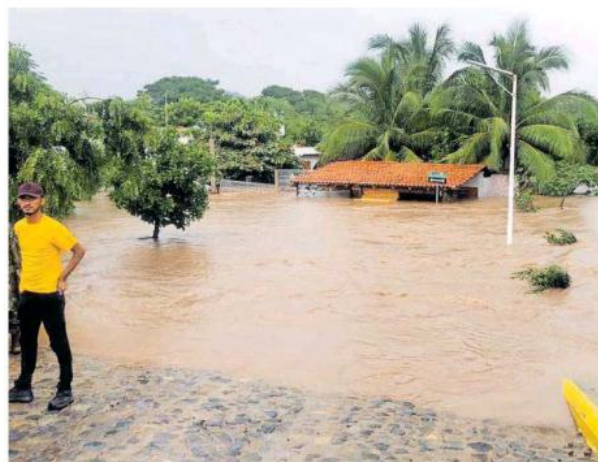
Algunas casas en la delegación de Chamela, en La Huerta, quedaron completamente bajo el agua. Fotos: Protección Civil
