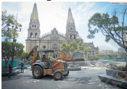
INTERVENCIÓN. Se espera que las obras en Plaza Guadalajara duren cinco meses; en ese lapso se rehabilitará la fuente, se sustituirá piso y arbolado, se restaurarán bancas y se dará mantenimiento a locales subterráneos, entre otras acciones.
