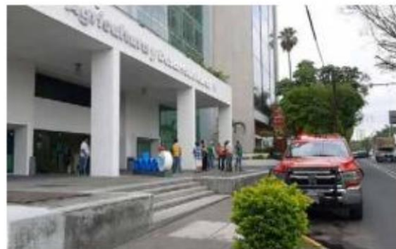
POR CHAPU. En Guadalajara fue desalojado el edificio de la Sader de manera preventiva.
