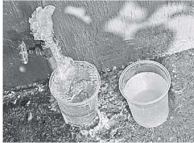
El gran problema es la antigüedad de las tuberías. CORTESÍA.
