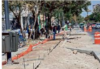
■ Los frentes de obra debían terminarse a finales de noviembre.
