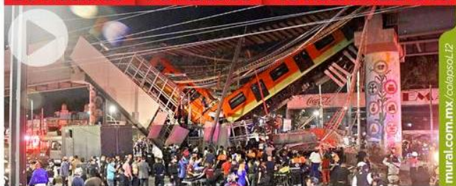
1 Dos vagones del Metro cayeron sobre autos que circulaban en la Avenida Tlahuac.
