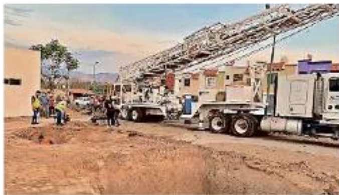
■ En Valle de Los Molinos, en Zapopan, se perfora un nuevo pozo para abastecer de agua a esa zona habitacional.
