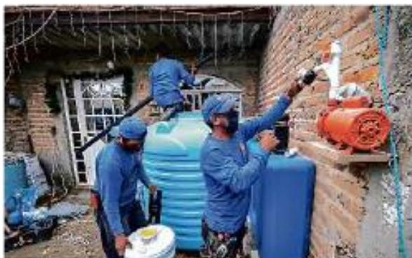
Las cisternas colocadas tienen capacidad de captar 2 mil 500 litros de agua durante el temporal.
