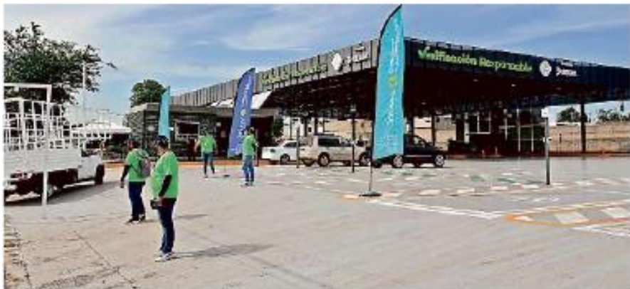
Centro de Verificación Vehicular sobre Carretera Libre a Zapotlanejo, en la Colonia San Pedrito.
