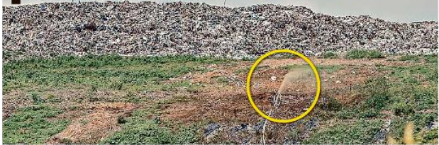
GÉISER DE LIXIVIADOS. Las tuberías del vertedero registraban una fuga que liberó lixiviados a la atmósfera.
