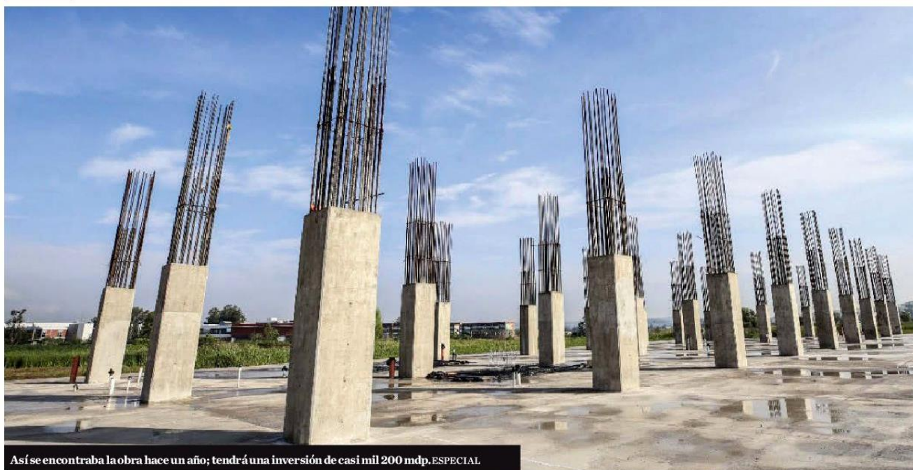
Así se encontraba la obra hace un año; tendrá una inversión de casi mil 200 mdp. ESPECIAL
