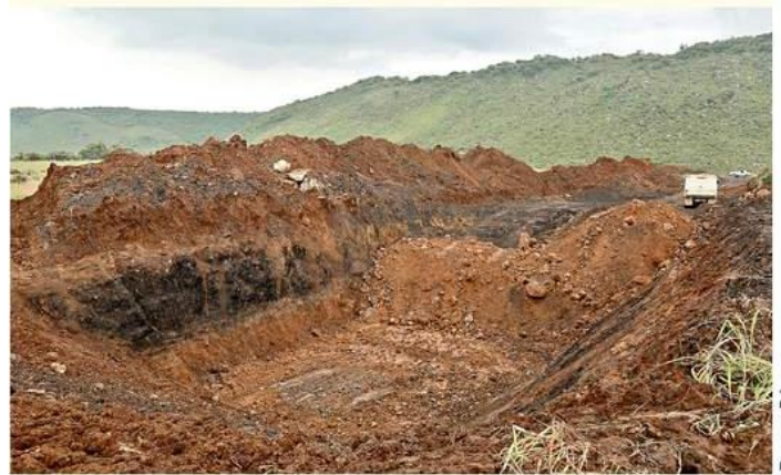
El nuevo relleno se construye en un predio agrícola de Tala.
