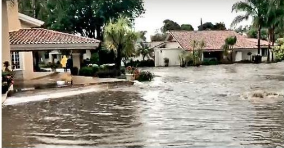
El drenaje del condominio Santa Anita Club de Golf colapsó y estuvo brotando agua por los pozos de visita.
