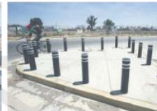
INSERVIBLES. Constructoras colocan de forma direccional los postes (zona de Bosques Vallarta).
