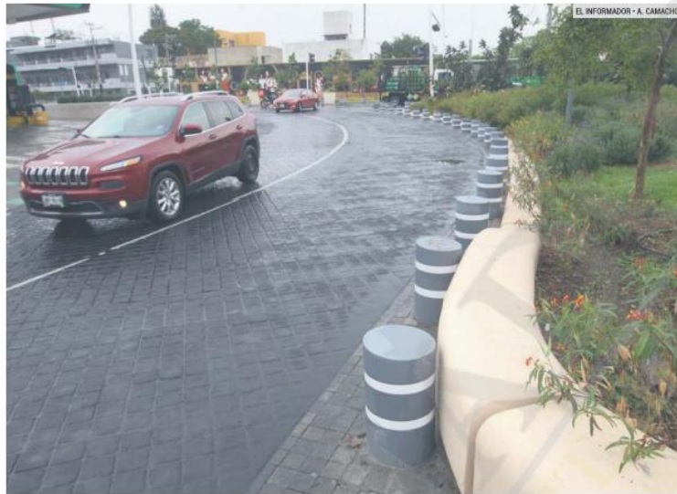
"PROTECCIÓN". Los bolardos tienen el objetivo de proteger al peatón, pero se instalan en puntos inútiles con cargo al erario. En la imagen, la zona de los Arcos de Zapopan.
