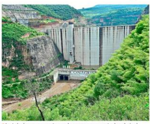
Instalarían compuertas en la presa para controlar el nivel del agua y evitar inundaciones en poblados aledaños.
