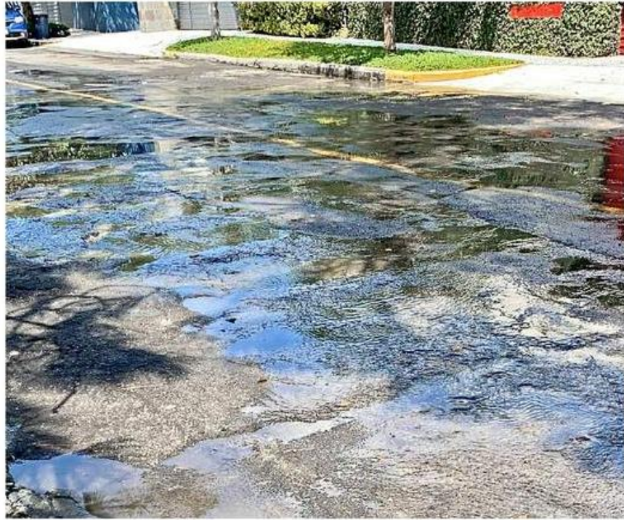
■ El agua de la alcantarilla corre por la Calle Loma Larga.
