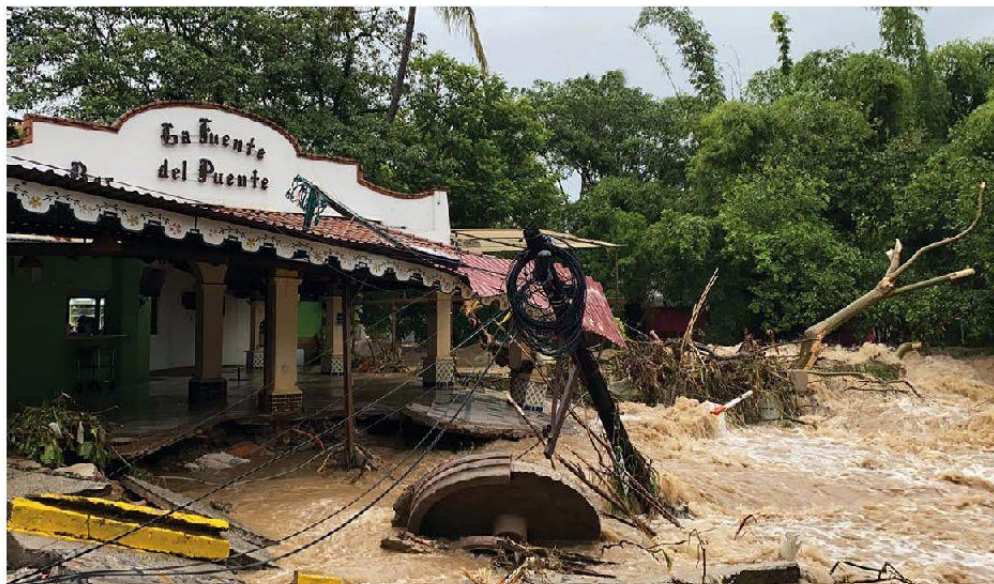
Las inundaciones causaron daños en infraestructura. ESPECIAL
