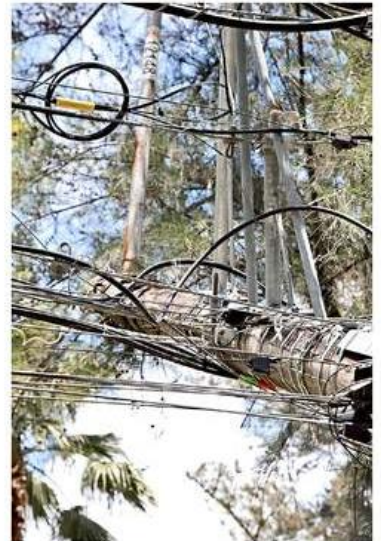
■ Vecinos de La Calma se quejan del exceso de cableado en la zona.
