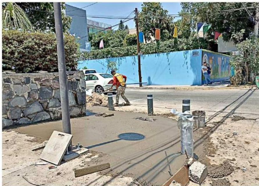
Personal de Obras Públicas acudió a la Calle Herrera y Cairo a realizar el colado para terminar las esquinas y dejarlas, ahora sí, con accesibilidad universal.
