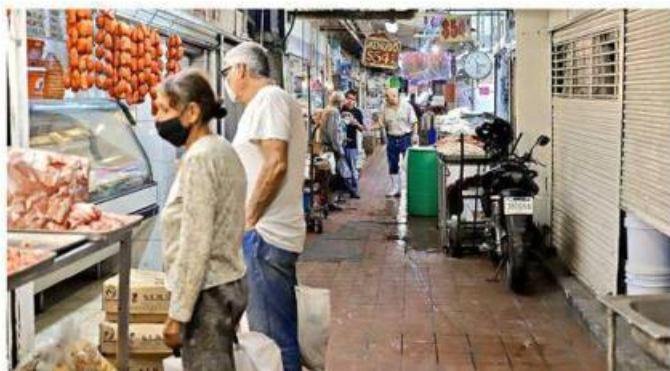
■ Aspecto del interior del Mercado San Juan de Dios, luego de que la lluvia del viernes ocasionara algunos daños.
