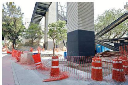
■ El acceso peatonal de la estación Periférico Belenes sigue en construcción. Tiene tambos y mallas para restringir el paso.
