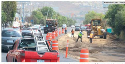
TRABAJOS. En mayo pasado comenzó la construcción de la Línea 4, que beneficiará a los habitantes del Sur de la ciudad.
