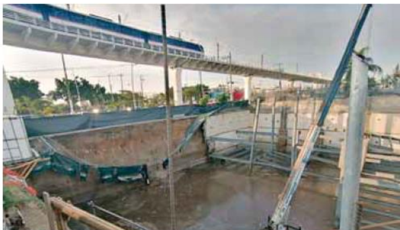
Descartan daño. No hubo daño alguno a la infraestructura del viaducto de la L3. /SITEUR
