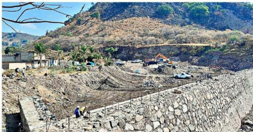
■ Zapopan invirtió 90 millones de pesos en obras en el Arroyo Seco y el Tempisque.
