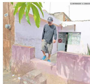
AFECTADO POR LAS LLUVIAS EN GUADALAJARA. Guillermo Lemus levantó sus bardas un metro para evitar que vuelva a entrar el agua a su hogar.
