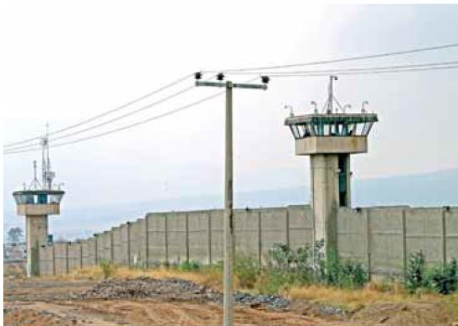
Abandono. Tras el cierre del Cefereso en 2020, el inmueble se encuentra abandonado. / CUARTOSCURIO
