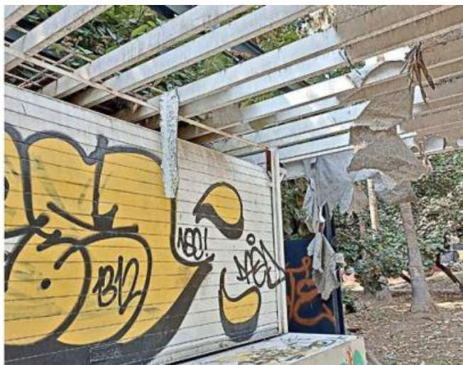
En estas condiciones se encuentra parte del parque extremo ubicado en Circunvalación y Normalistas.
