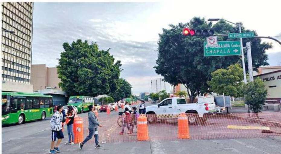
■ Policías viales apoyaron ayer en los cierres a la circulación y desvíos por las obras.
