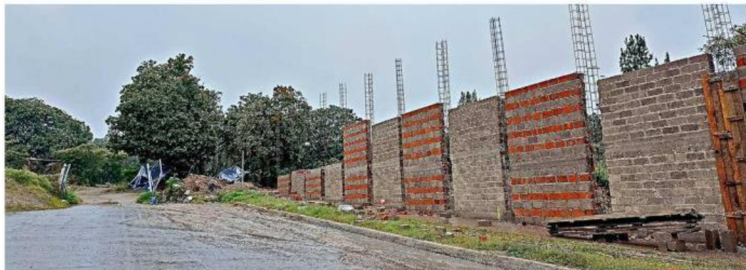
■ El predio en donde ya comenzaron los trabajos se encuentra entre Circuito del Lince y Circuito del Lince Sur, en Bugambillas.
