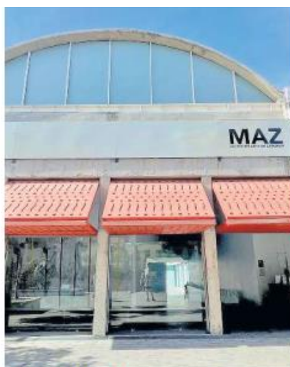
FACHADA DEL MAZ. Las Obras selectas de la Colección de la Fundación de Arte Cisneros Fontanals se exhibirán a partir del 4 de septiembre.
