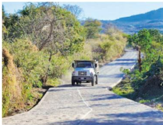
Este año se ejercerá un presupuesto de 117.4 millones de pesos, en la rehabilitación de 118 caminos de 34 municipios.
