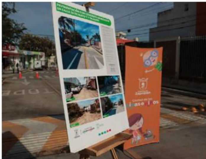
OBRAS. El gobierno de Zapopan entregó vialidades en la colonia Hogares de Nuevo México. Las obras incluyeron pavimentación con concreto hidráulico y sustitución de redes hidrosanitarias.
