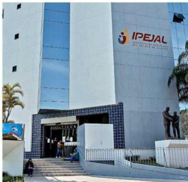
Los señalados son ex funcionarios del Ipejal y ya habían sido vinculados por otra carpeta sobre Abengoa.
