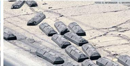
DESGASTE. La infraestructura que divide los carriles se encuentra en mal estado en varias estaciones.
