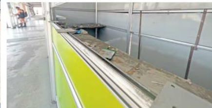
ABANDONO. Falta brindar mantenimiento a los espacios de atención de los usuarios. Algunos lucen llenos de basura.
